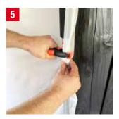
Para terminar el plástico debe ser sujetado a lo largo del puntal. Para ello usar cinta adhesiva, o como se ve en la imagen, usar las pinzas para una sujeción mas rápida.
