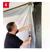
Cuando el puntal este vertical entre el suelo y el techo, girar el mango en en sentido de las agujas del reloj para dejarlo fijado firmemente.
